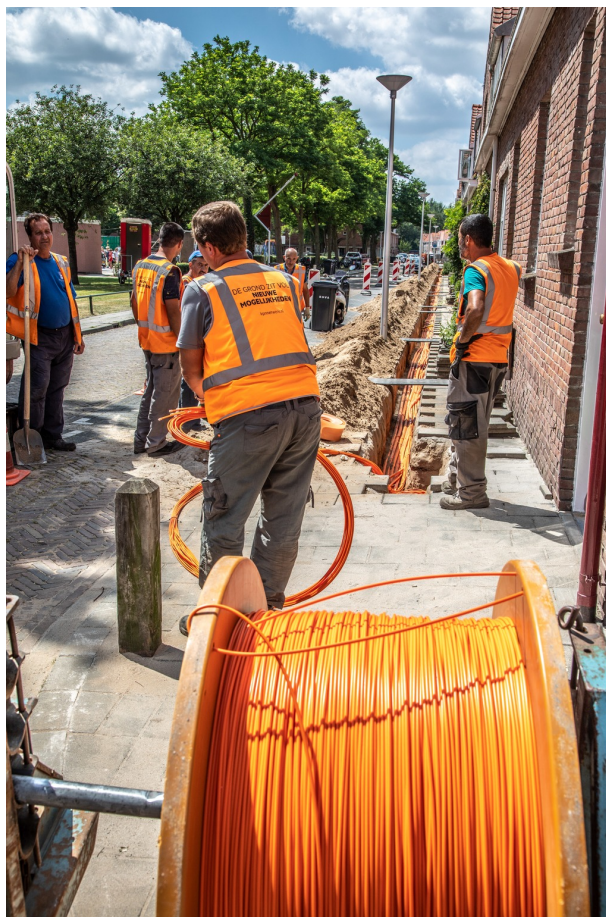
OVER ENIGE TIJD WORDT DIT OOK HET BEELD IN SPIJKENISSE EN ZUIDLAND. HIER IS KPN DRUK BEZIG MET GLASVEZELKABEL IN ZWOLLE. FOTO FRANS PAALMAN
